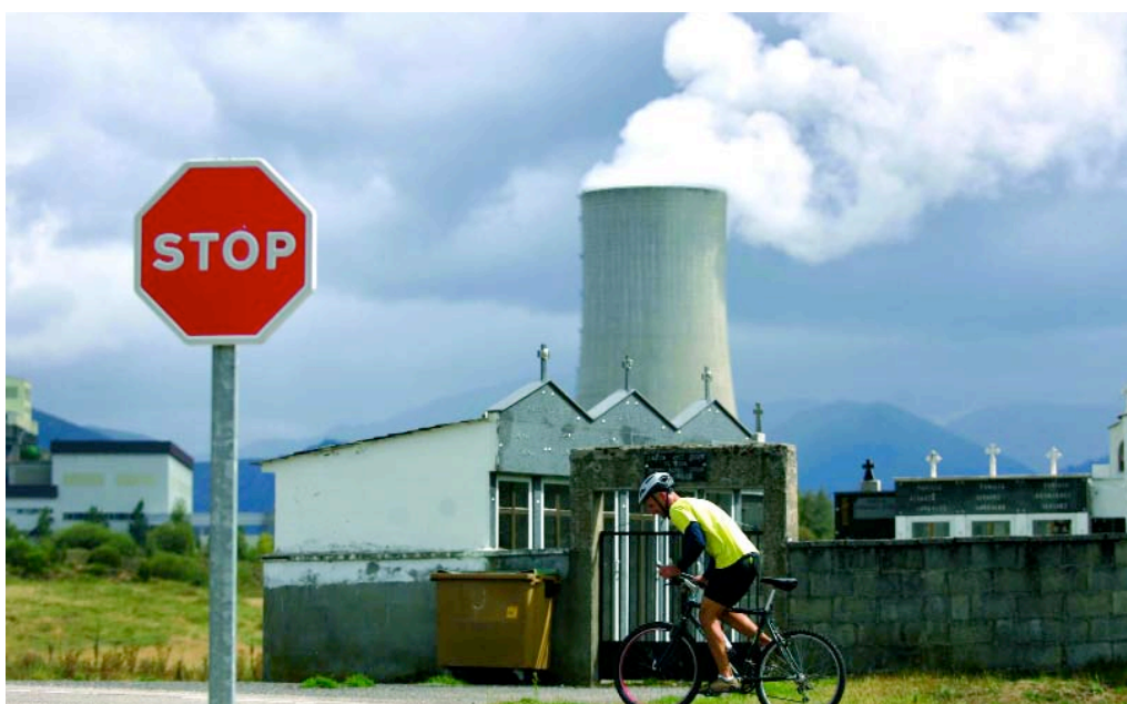
5.1.irud.- Anllaresko Zentral Termikoa, (León).
